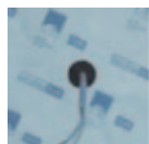
Těsnicí manžeta pro vodotěsné a větrotěsné napojení prostupů přes poj. hydroizolace, viz str. 35
